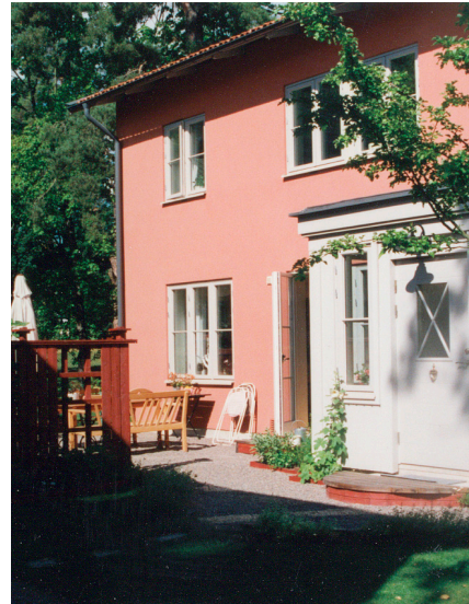
Exempel på putsad fasad.
