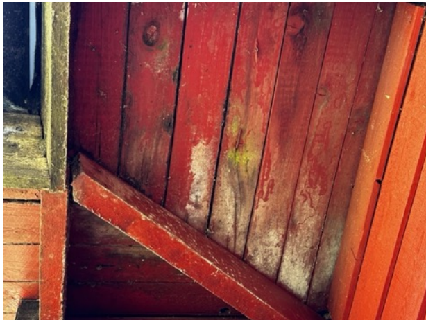
Missfärgat på takfot vid rännalslut
