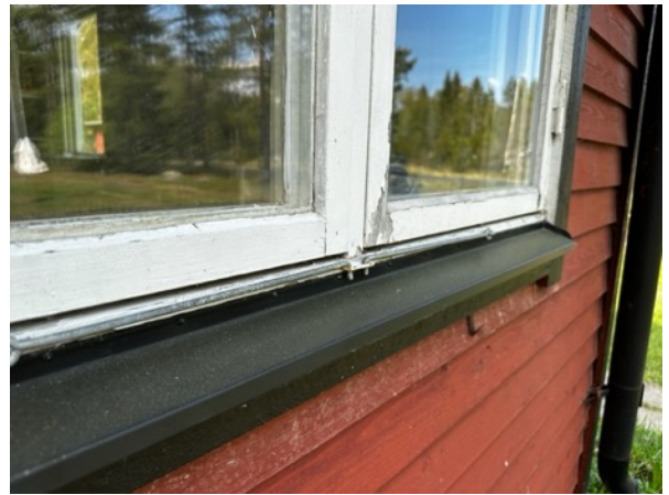
Färgsläpp på snickerier
