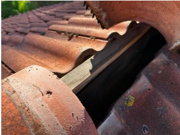
Nocktätning saknas
