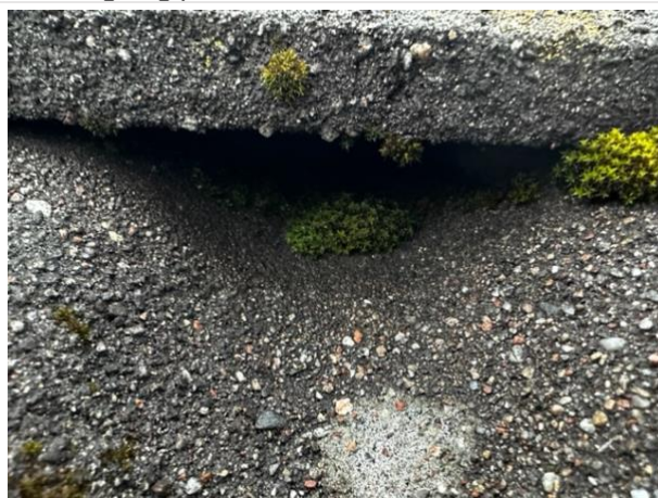
Nocktätning saknas
