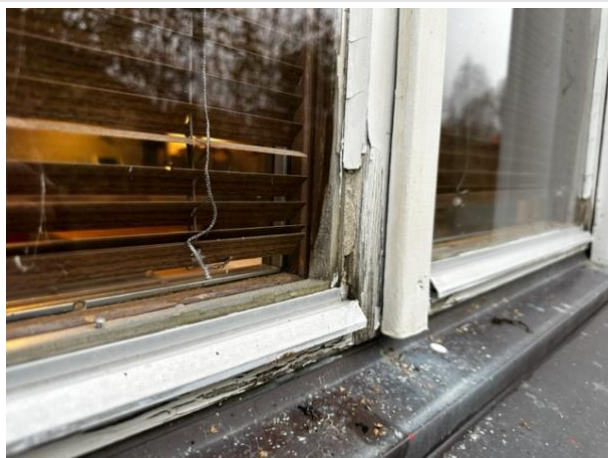
Röta och färgsläpp på snickerier
